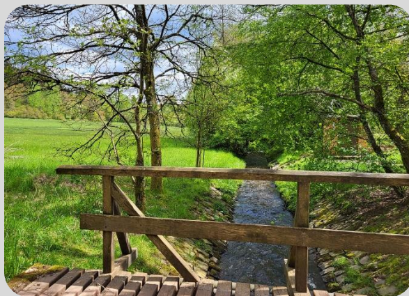
Überquerung Losheimer Bach
