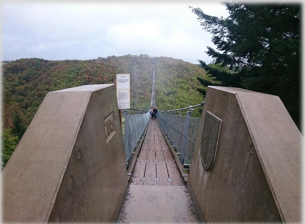
Hängeseilbrücke Sicht aus Richtung Sosberg
