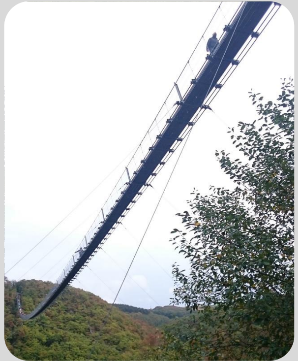
Hängeseilbrücke von unten
