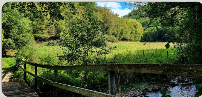
Schafpühlbrücke über der Dhron
