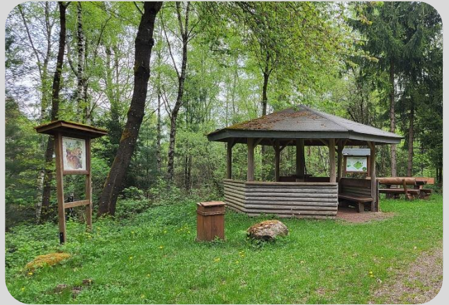
Schutzhütte am Hoxberg
