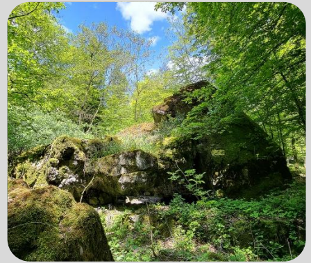
Stellung am ehem. Westwall
